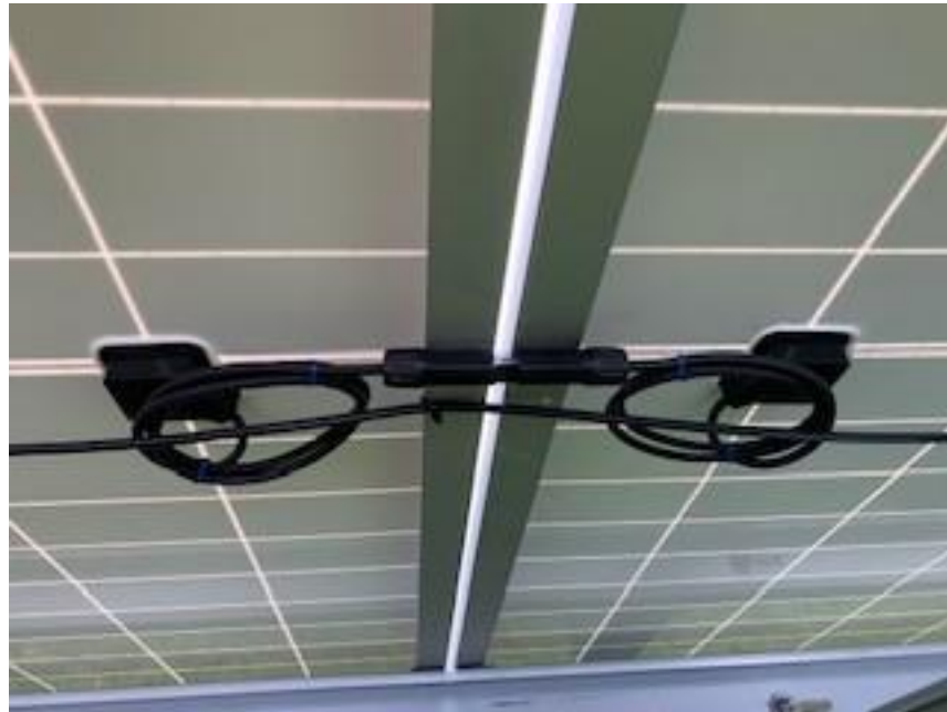
Illustration 187 : Vues des interstices de 2 cm entre chaque panneau
